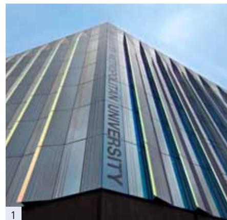
Das Foto 1 zeigt die Fassade der Business School der Manchester Metropolitan University. 4000 m 2 Glas wurden mit einer dichroitischen Folieneinlage und Siebdruck auf Pos. 1 + 4 laminiert.
